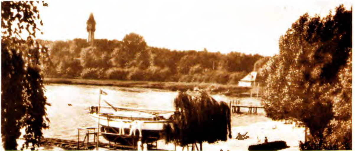
Blick auf Schwanenwerder mit dem 1911 erbauten Wasserturm im Jahre 1937
